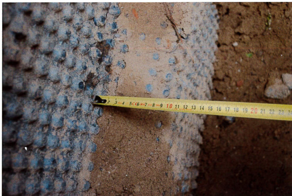
POMIAR ODSADZKI ŁAWY FUNDAMENTOWEJ
