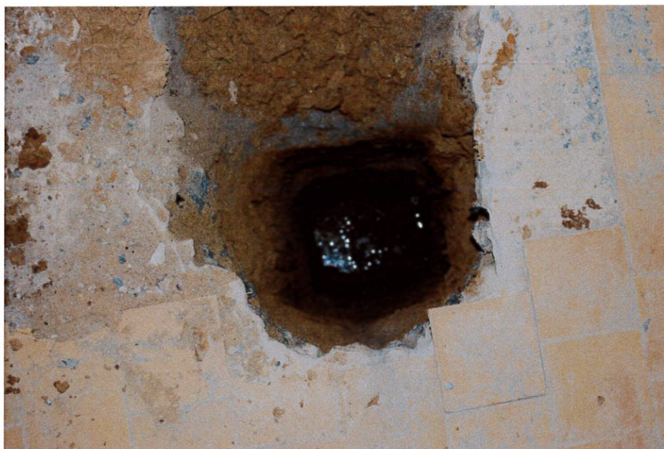
WIDOK ODKRYWKI WYKONANEJ WEWNĄTRZ BUDYNKU W POMIESZCZENIU ŁAZIENKI
