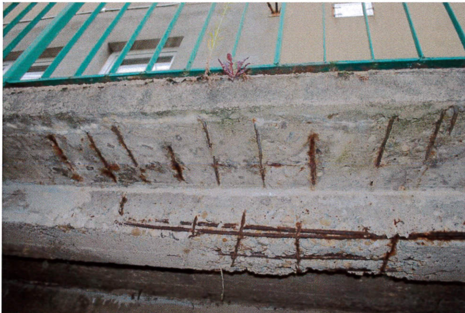
WIDOK PODNIEBIENIA PŁYTY TARASU
