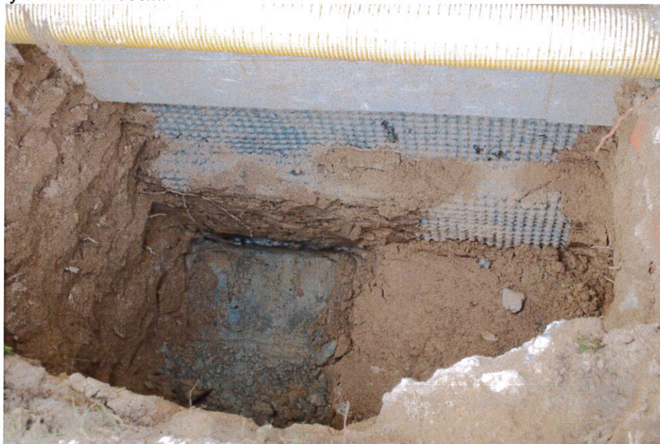
ODKRYWKA FUNDAMENTÓW NA ZEWNĄTRZ BUDYNKU
