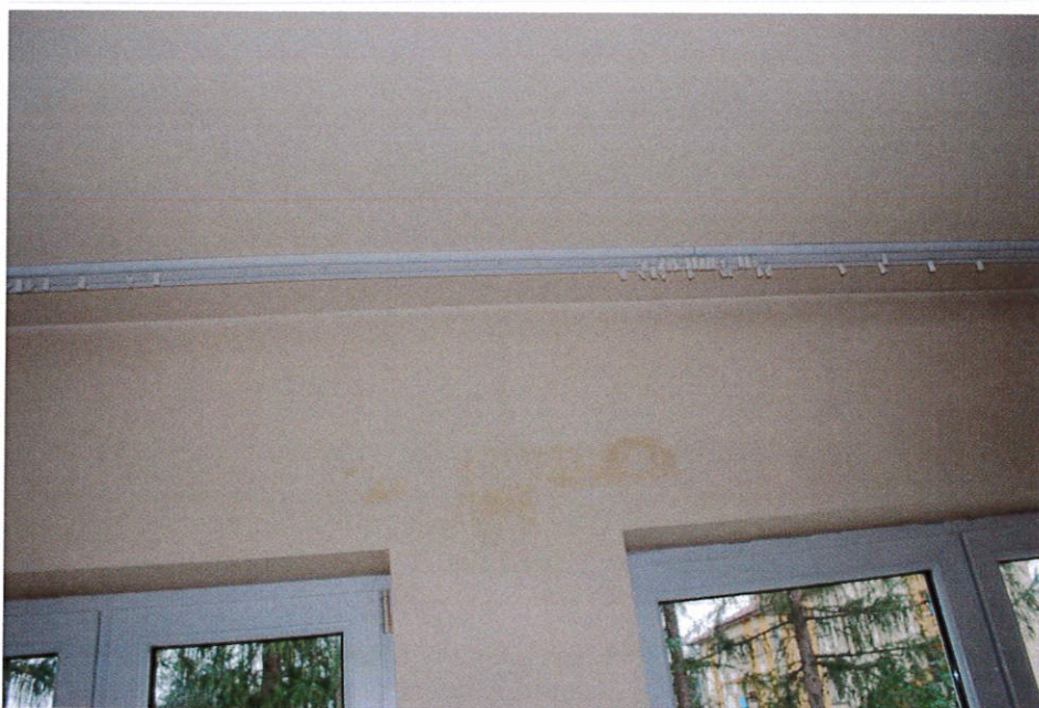
WIDOK ŚCIANY PARTERU Z WIDOCZNYMI SPOINAMI POMIĘDZY PUSTAKIEM
