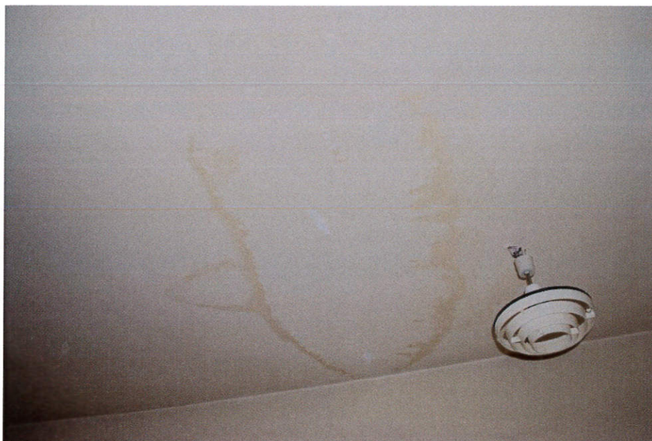
WIDOK PŁYTY NAD PIĘTREM
