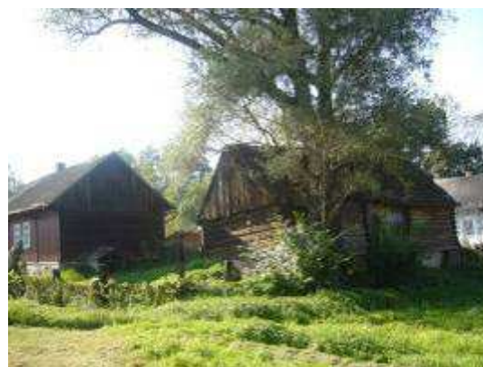
Fot. 34. Niszcząca zagroda o cechach zabytkowych w sołectwie Łazy (Fot. B. Szwed)
