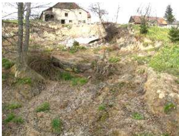
Fot. 7 Osuwisko w Łazach zburzyło stodołę (Fot. K. Fastnacht-Kundzierewicz)
