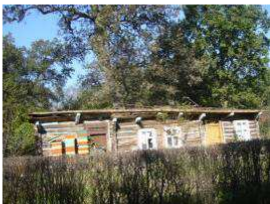
Fot. 33. Przekształcające się w ruinę budynek mieszkalny o cechach zabytkowych w sołectwie Jodłówka (Fot. B. Szwed)
